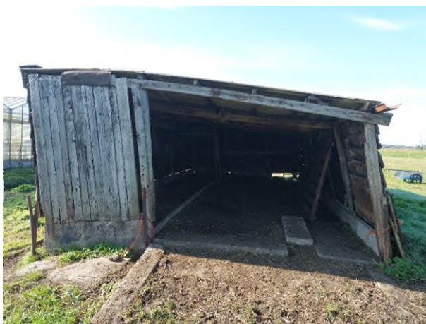
Fotonummer: 11 Omschrijving: Uiteinde goot aan noordoostkant asbestverdachte dak (foto richting zuidwest)
