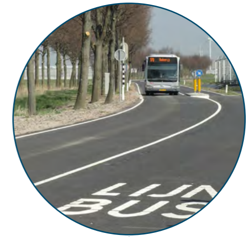
vrijliggende dubbele busbaan
