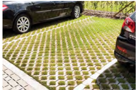
Parkeerplaatsen van grasbetontegels
