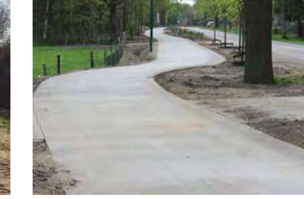
Voetpaden ook uitgevoerd in circulair of duurzaam beton
